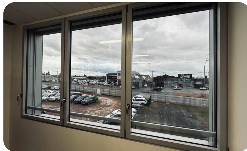
Réalisation FilmsProtect - vue depuis l'intérieur.
